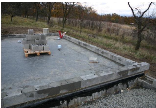
Obr. 9 Realizace prahu z tvárnic Neico – Střelice
