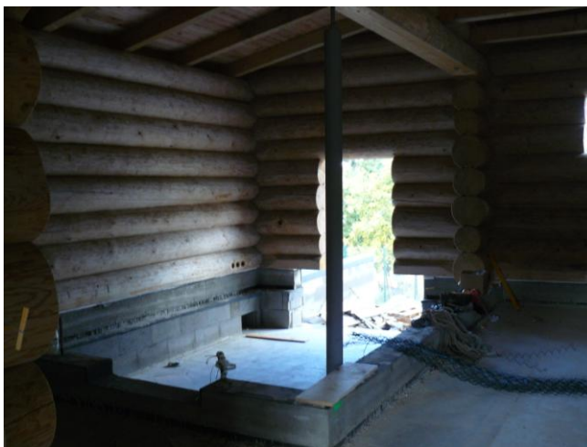
Obr. 12 Železobetonový prah s podkladem z desek Foamglas – Olešná u Blanska
