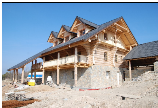
Obr. 3 Ukázka realizace (před dokončením)
